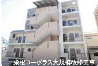
栄根コーポラス大規模改修工事
