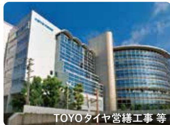
TOYOタイヤ 営繕工事等
