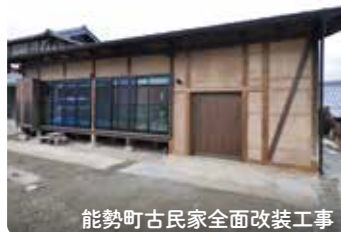
能勢町古民家全面改装工事
