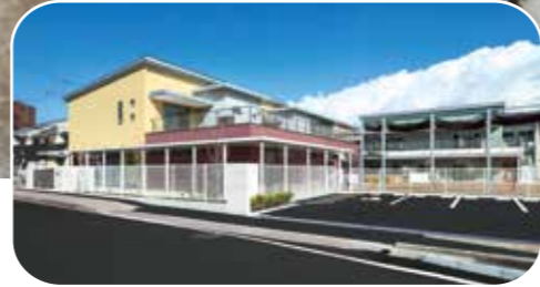
川西市立川西北こども園 新築工事
