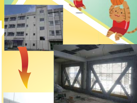
水平プレス補強工法 2011 川西北小学校 体育館
