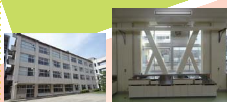
鉄骨プレス補強工法 2015 川西北小学校
