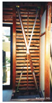
「ハードロックII」+耐力面材による補強
