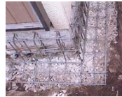
「外周片面打増工法」を採用し、床板を取り除くことなく、住まいの外周から基礎を補強します。
